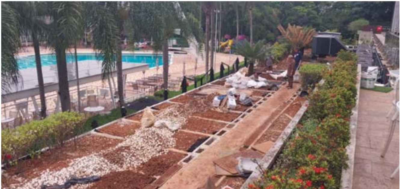
IMPERMEABILIZAÇÃO DA MARQUISE DO RESTAURANTE AMANI
