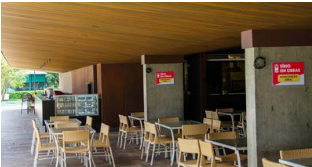
TROCA DOS PAINÉIS DA MARQUISE NA ENTRADA DO RESTAURANTE AMANI
